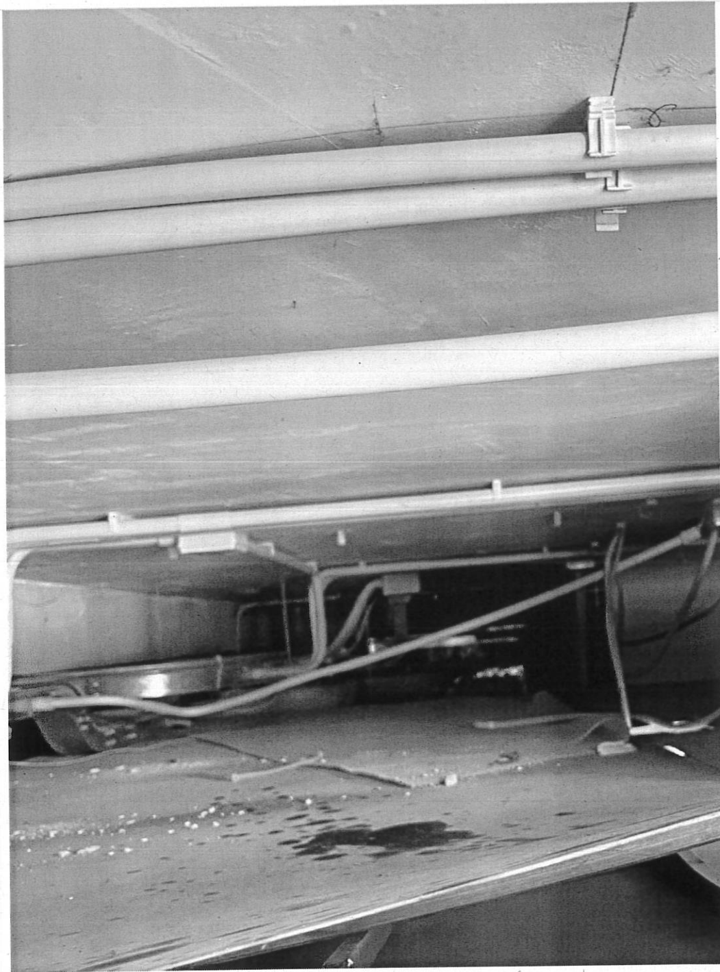
fig.6 – Particolare intradosso solaio
