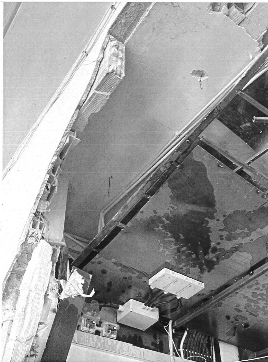
fig.7 – Particolare copertura caveau
