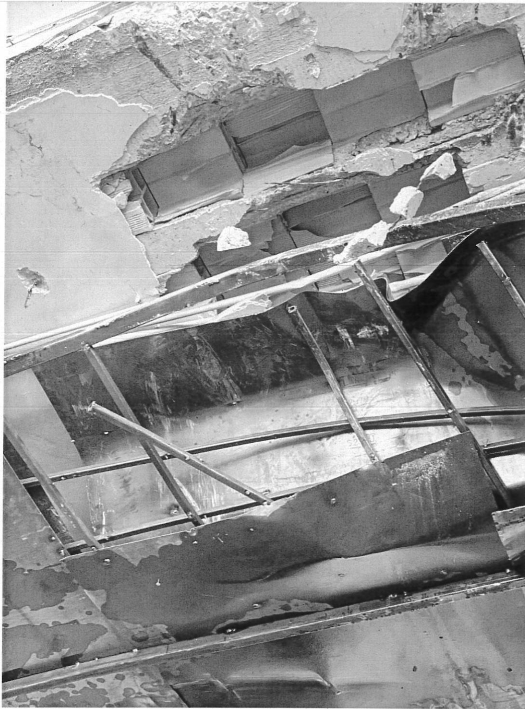
fig.5 – Particolare copertura in acciaio caveau
