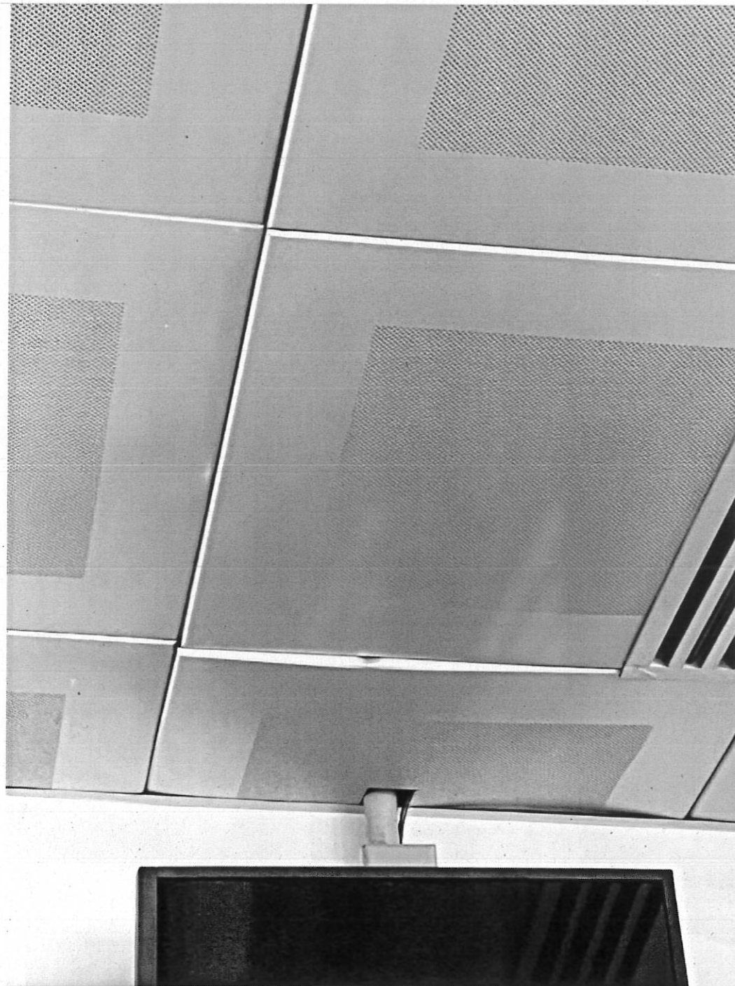
fig.9 – Particolare controsoffitto sulla parete di confine tra caveau e sala al pubblico
