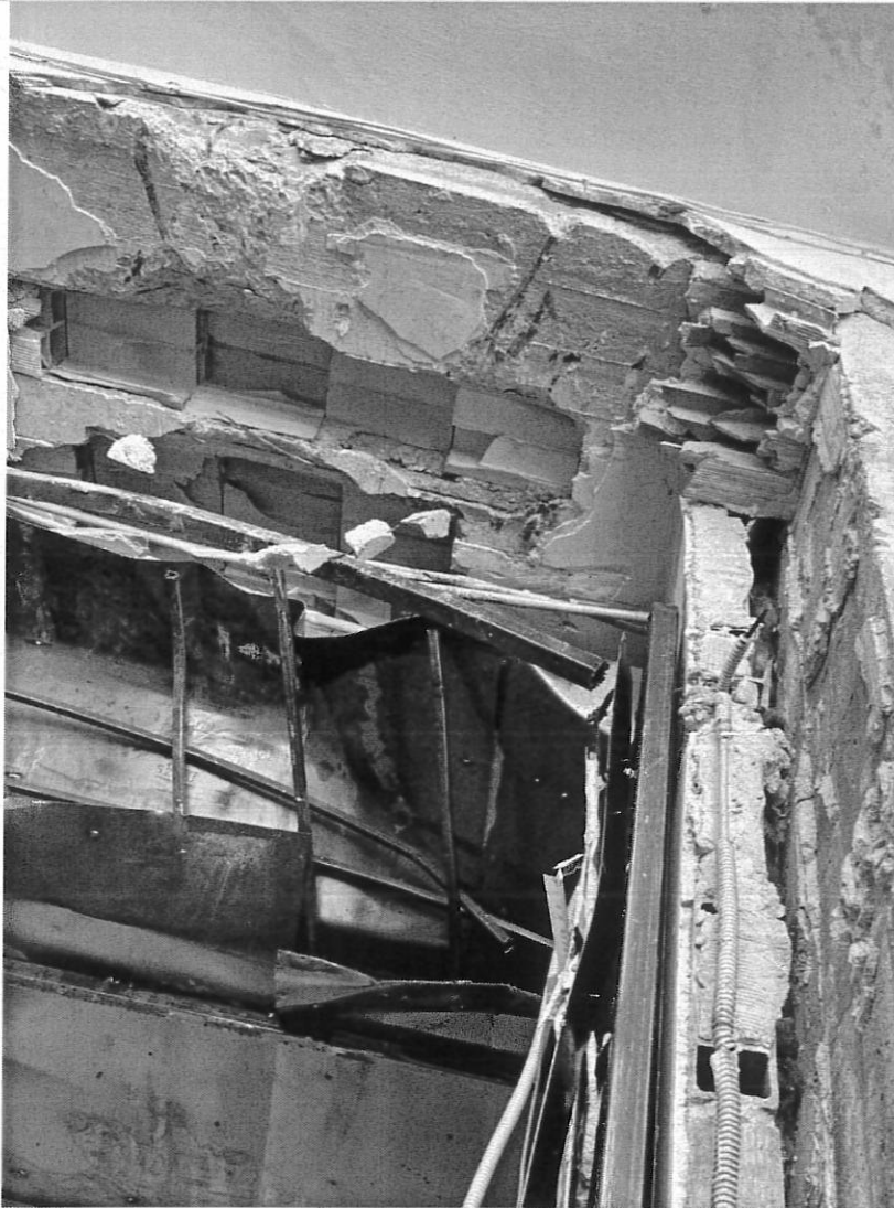
fig.3 – Particolare travi e pilastri prospicienti il caveau
